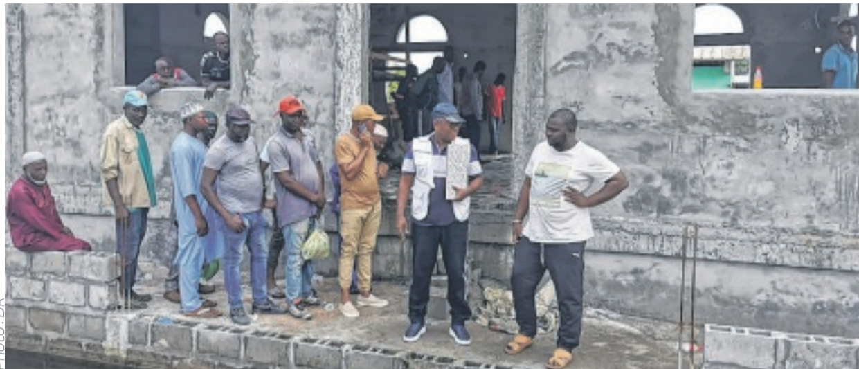
La délégation de l'imam Bekoye et du député Otandault, lors de la visite du chantier..
